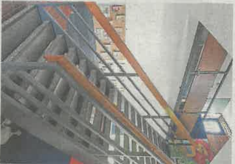
Der Stadttreff soll im Zuge der Sanierung auch behindertengerecht werden.
